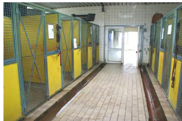
Das Hundehaus vor der Sanierung
