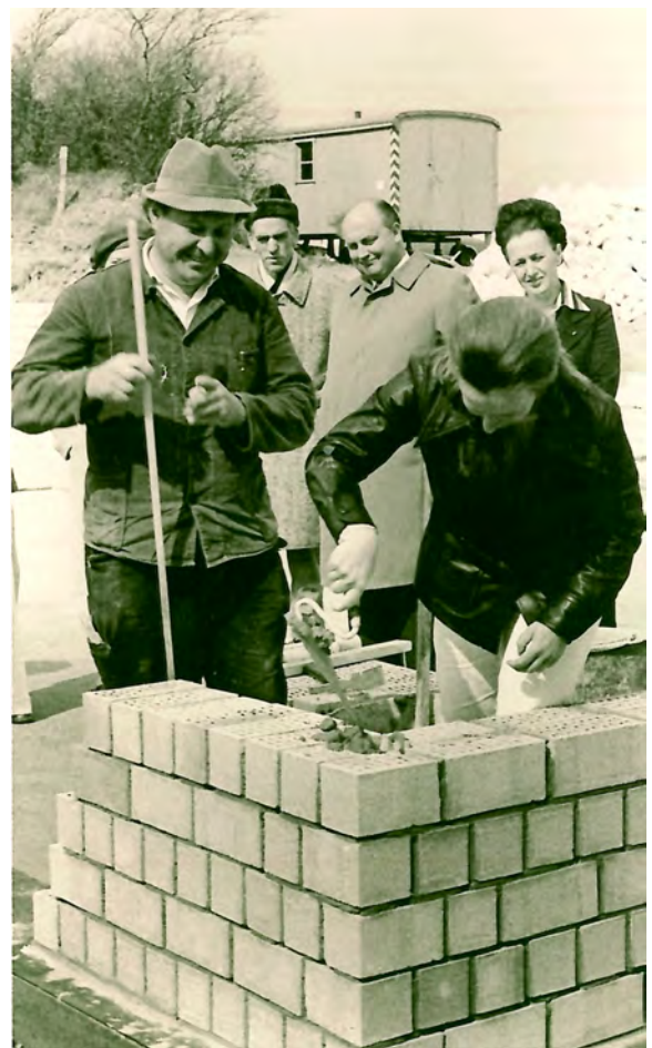
Am 26. April 1974 wurde der Grundstein für den 1. Bauabschnitt des Tierheims
